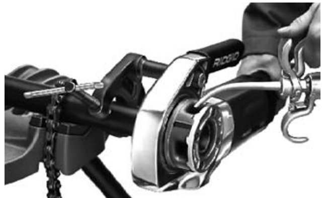
Figure 6 – Filetage des tuyaux et application de l'huile
