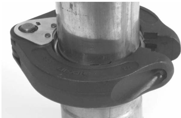
Figure 13B – Installation d'une bague ProPress XL-C sur le raccord
